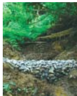
湧水の流れを作る手作りダム
