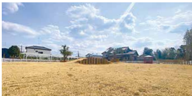
建設中のドッグラン
